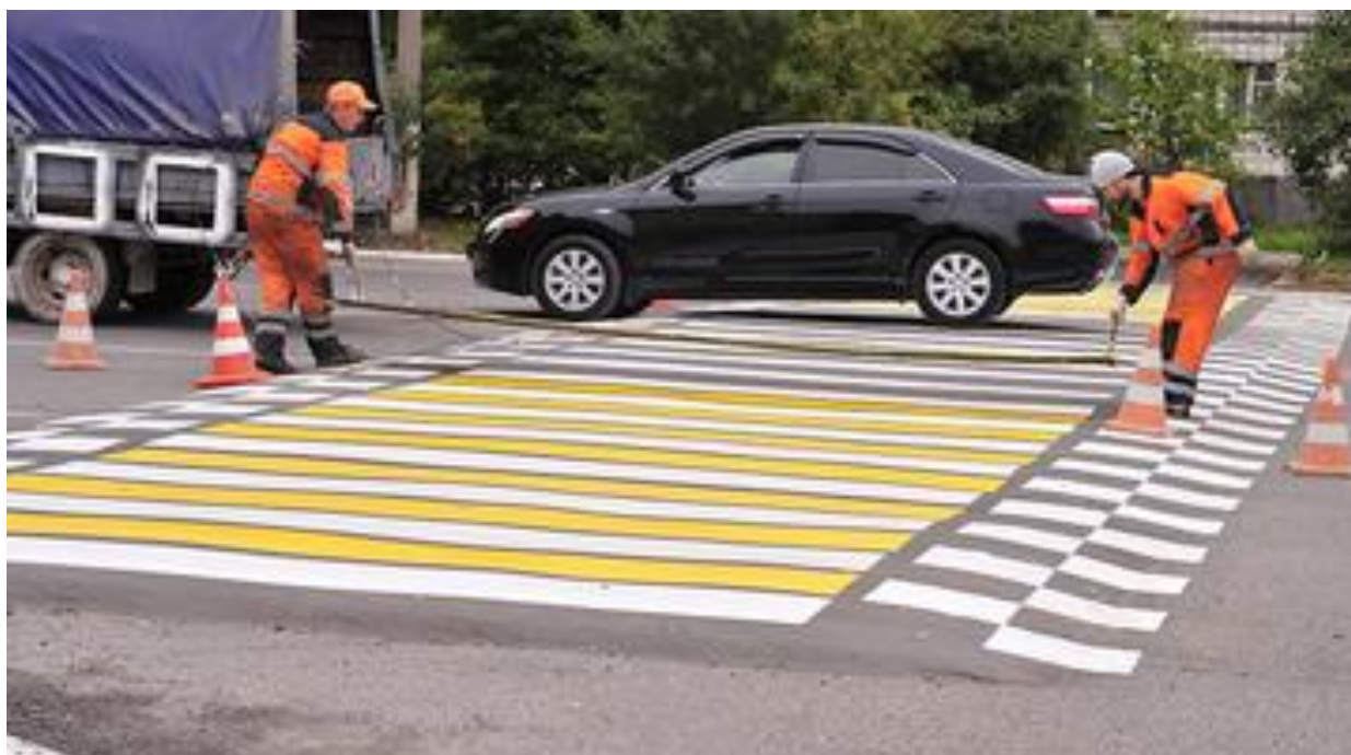
Рис.3.3 – Пример устройства пешеходного перехода на уровне тротуара.
